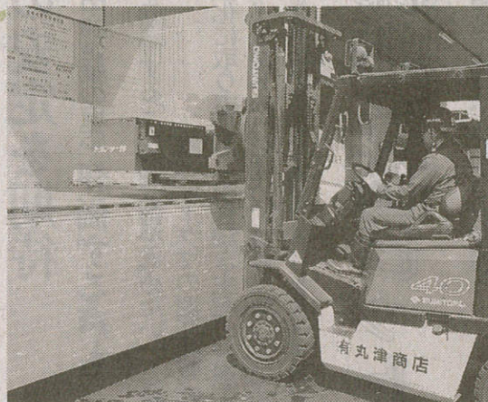
鉛バッテリーの処理作業の様子
